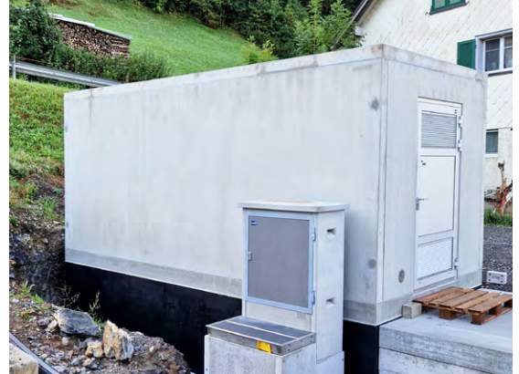
Trafostation Beglingen 18a in Mollis im Rohbau
