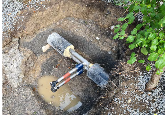
Neuer Fernwärmeanschluss in Vorbereitung
