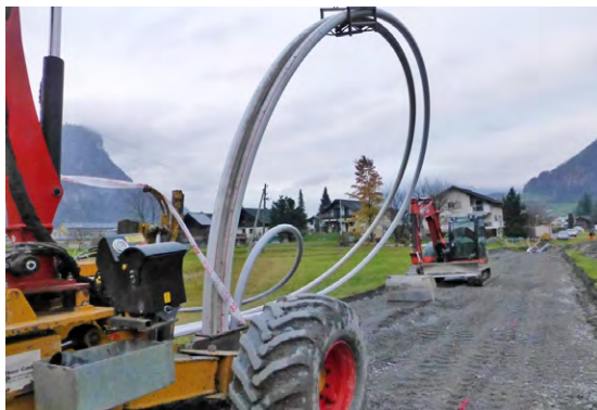
Werkleitungssanierung Allmeindstrasse – Moosbach in Mollis
