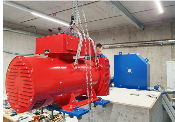
Montage des Turbinengehäuses und des Generators im Trinkwasserkraftwerk Paradiesli in Mollis
